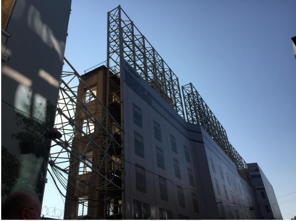
Şekil 3.18 : Paket Postanesi'nin iç yıkım sonrası cephesinin bırakılması, 2018.
