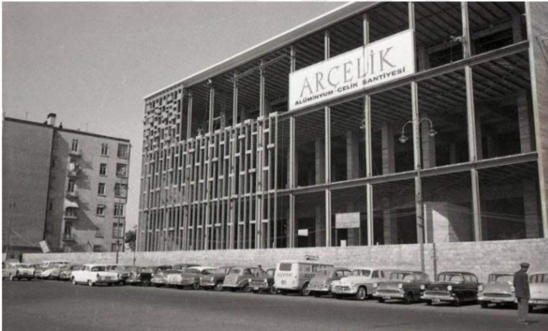
Şekil 3.16 : AKM cephe inşaatı (Gür, 2018).
