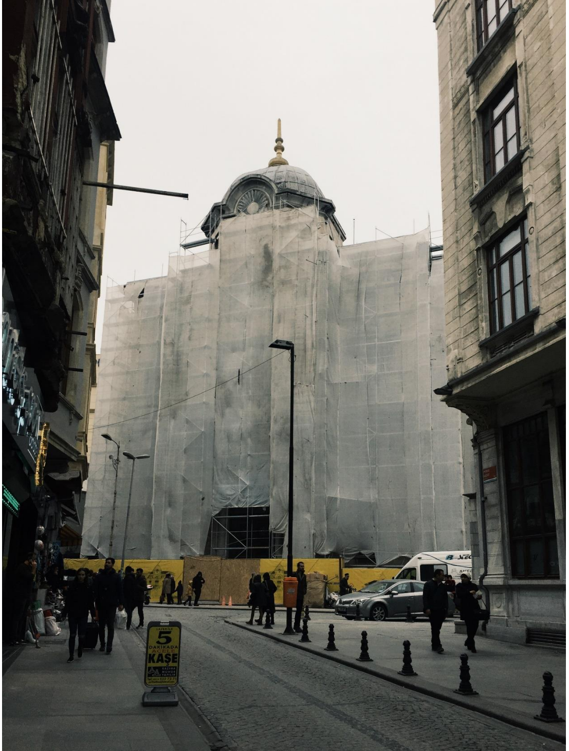
Şekil 3.8 : Sirkeci’de restorasyon çalışması, 2018.
